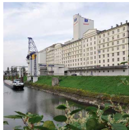
Plange-Mühle: Standort Neuss
